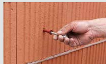
Dübel (ggf. bereits mit Schraube) ansetzen.
