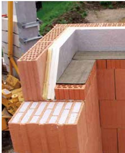
Deckenaufleger mit Deckenabmauerungsziegel
