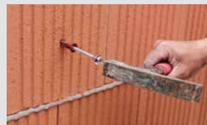
Dübel mit Hammer bündig einschlagen.
