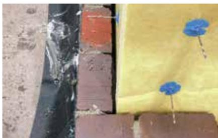
Die Verwendung von Tropfscheiben oder Klemmscheiben mit Abtropfnasen (Bild 5) verhindert, dass Feuchte über den Anker von der Außen- zur Innenschale gelangt.
