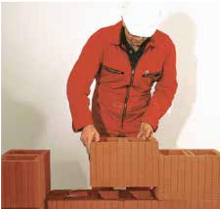
PFZ-T mit der Unterseite in den Dünnbettmörtel
