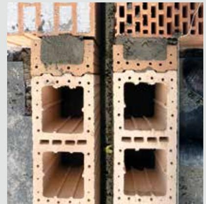
Für das Erreichen des vorberechneten Schallschutzes ist die saubere und vollständige Trennung beider Wandschalen wichtig.
