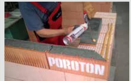
Zur Stabilisierung des Eckbereichs die Schnittfläche mit Poroton Dryfix-Kleber verkleben.
