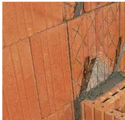
Wandanschluss: Stumpfstoß mit Flachstahlanker und satt vermörtelter Stoßfuge oder noch besser: Schlitzeinbindung in die Außenwand
