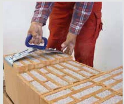
Setzen: Ziegel einfach in die Verzahnung des Nachbarziegels setzen
