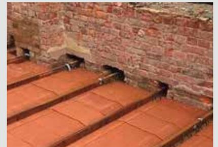
Nach Auflegen der Träger auf den höhenmäßig abgeglichenen Wandkopf und Einlegen der Einhängenziegel wird durch Einbringen des Vergussbetons (C25/30, Konsistenzklasse F3) ein tragfähiges Verbundsystem ausgebildet. Sofern erforderlich, kann durch zusätzliches Aufbringen eines Aufbetons von 3 cm bis 10 cm Dicke die Tragfähigkeit und der Schallschutz verbessert werden.
