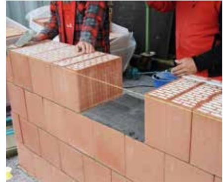
Bitumendachbahn R500 in Dünnbettmörtel verlegt beim Poroton-T7-P
