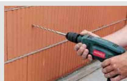
Bohren ohne Schlagfunktion mit scharf angeschliffenem Hartmetallbohrer.
